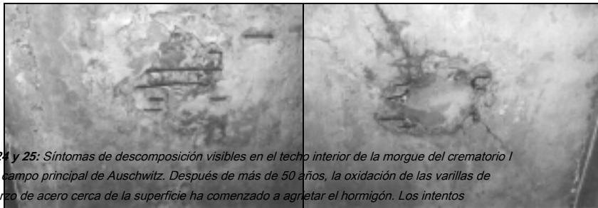
**Figs. 24 y 25:** Síntomas de descomposición visibles en el techo interior de la morgue del crematorio I en el campo principal de Auschwitz. Después de más de 50 años, la oxidación de las varillas de refuerzo de acero cerca de la superficie ha comenzado a agrietar el hormigón. Los intentos provisionales del Museo
